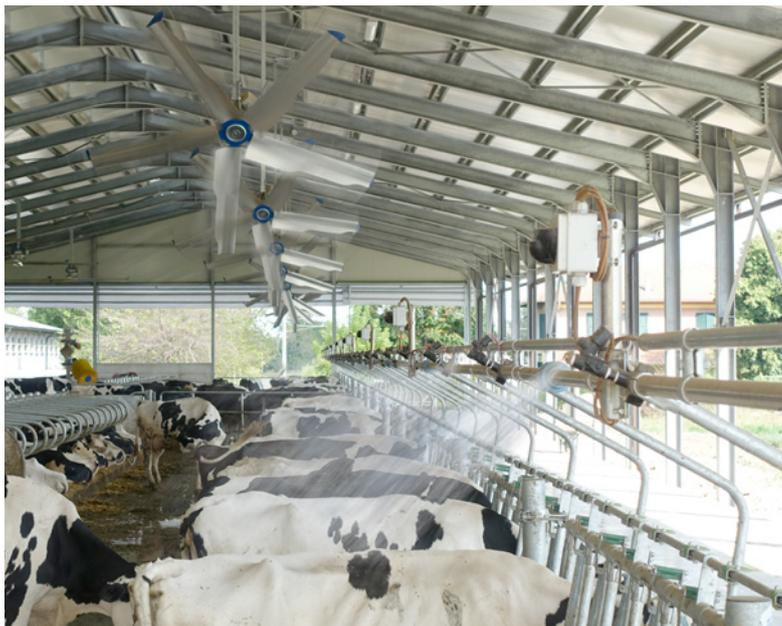
Der Vergleich zeigt eine Wassereinsparung von 38 % bei alleiniger Verwendung des I-BOX-Steuergeräts und mindestens 52 %, wenn das System mit Coolibri-Sensoren ergänzt wird; spürbar nicht nur im Hinblick auf die Kosten, sondern auch durch einen funktionalen Umgang mit den Ressourcen, ohne Verschwendung von Energie und Wasser!
